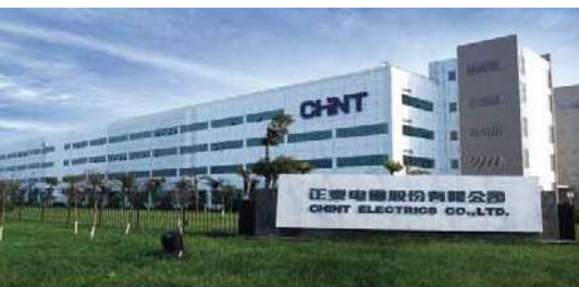
Parque Industrial de Aparatos Eléctricos (Wenzhou, Zhejiang)
