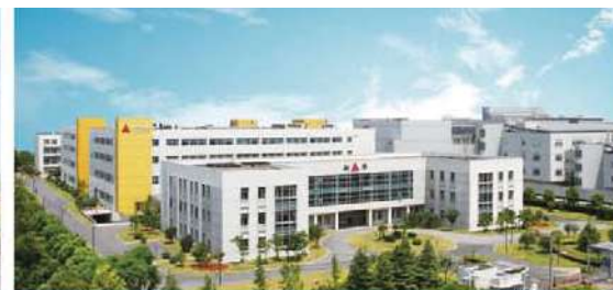
Parque Industrial de Automatización de Xinhua (Minhang, Shanghai)
