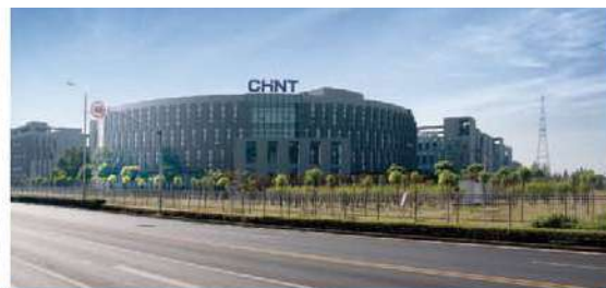
Parque Industrial de Transmisión y Distribución de Energía de CHINT(Songjiang, Shanghai)
