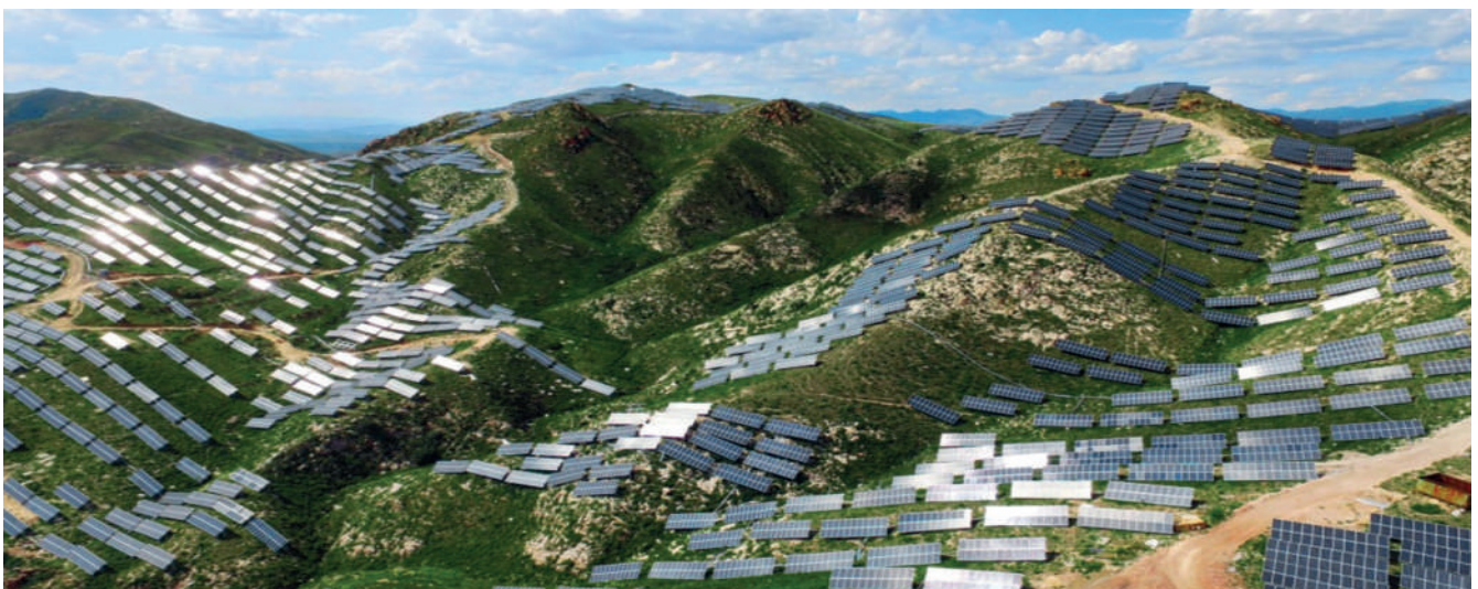
Astronergy 875 MW - Corredor Olímpico - Hebei, China
